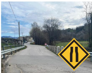
10 - Ponte verso Combai Svolta a sinistra su via Canal
