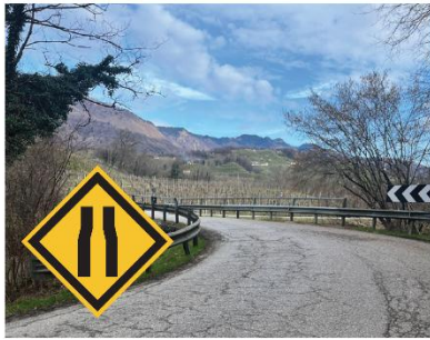
9 - Ponte verso Combai SP 152 Restringimento ponte
